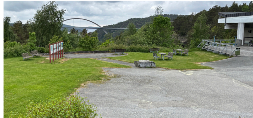
Utsikt mot nya Svinesundsbron från entré Norge
