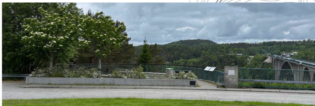
Utsikt mot gamla Svinesundsbron från entré Sverige
