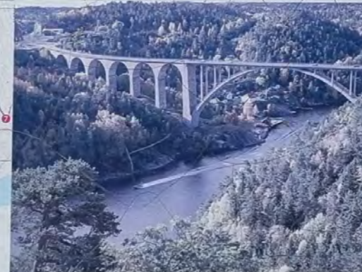
Gamle Svinesund bru fra 1946 er et imponerende skue fra Hjelmkollen. Det går tursti til Hjelmkollen, der det også er vernede rester av gammelt forsvarsanlegg.
